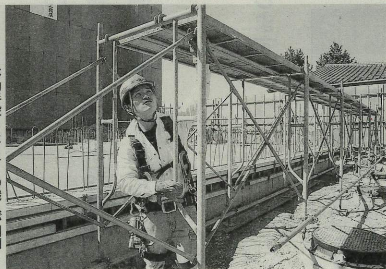
移動手段として多くの職人が利用するため、安全で使いやすい足場を設置する筒井大樹さん
